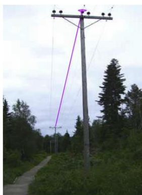
Figur 3.1c Exempel på kraftledning visualiserad genom långsgående och vertikala linjer. Den långsgående linjen konstrueras mellan redovisade brytpunkter och de vertikala linjerna konstrueras mellan brytpunkt och en markmodell, till exempel nationella höjdmodellen. Även 3D-symboler kan användas. Attributet variant kan användas för att exempelvis ange typ av luftledningsstolpe i fritext och därmed styra symbolen utseende. (3D-visualiseringen är hämtad från 3D-demonstratorn )
